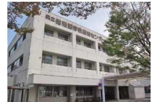
循環器呼吸器病センター 中央棟
