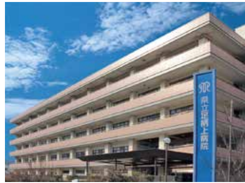
足柄上病院 3号館
