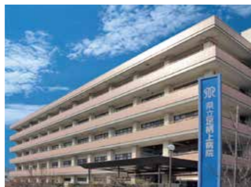
足柄上病院 3号館
