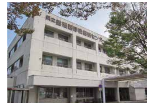
循環器呼吸器病センター 中央棟
